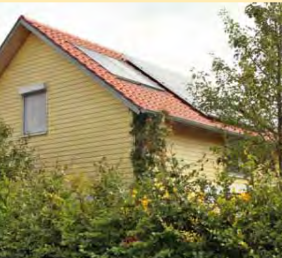
Brauchwassererwärmung und Stromerzeugung teilen sich die Dachfläche.
