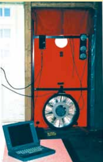
Blower-Door-Test im fertigen Rohbau.
