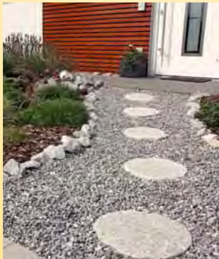
Dieser Zuweg lässt Regenwasser stilvoll versickern.
