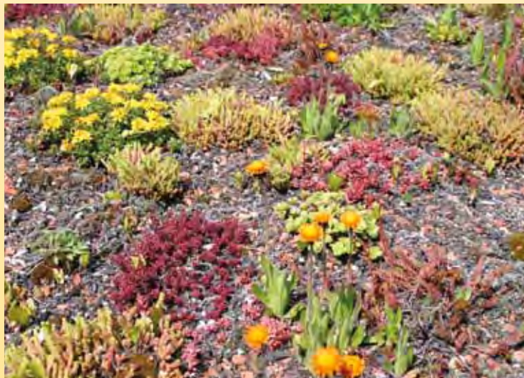
Extensiv begrünte Flachdächer sind pflegeleicht, schön anzusehen und schützen die Dachhaut.
