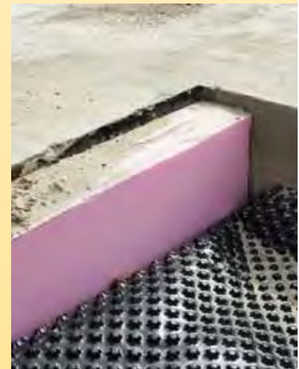
Die Sohlplatte wird rundum sorgfältig gedämmt.
